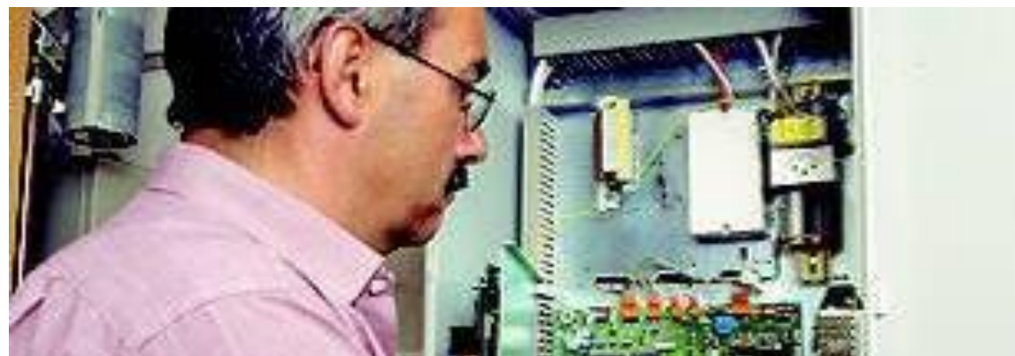
Монтаж и установка
